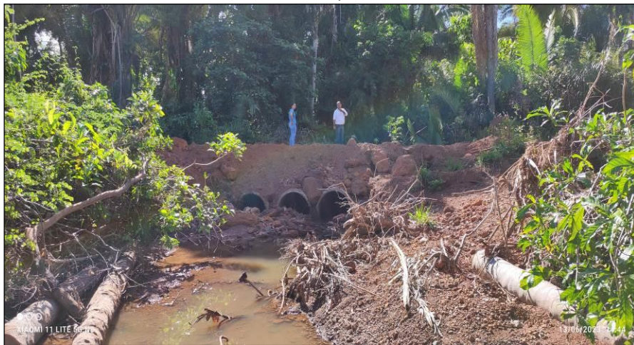
FIGURA 3: VISTA PARCIAL DA RECUPERAÇÃO DE BUEIROS ROMPIDOS NO RIACHO BOROCOTÓ, PA SACO DANTAS GUARIBAS, ITAPECURU-MIRIM/ MA.
