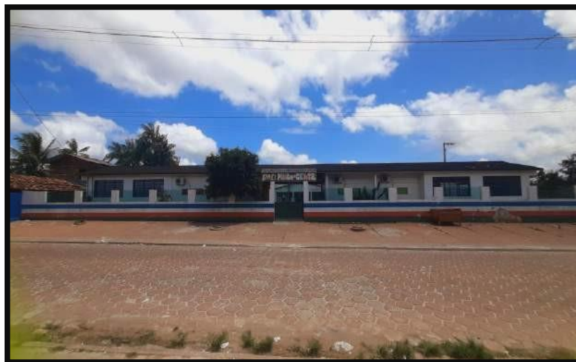
FIGURA 1: FACHADA DA ESCOLA
