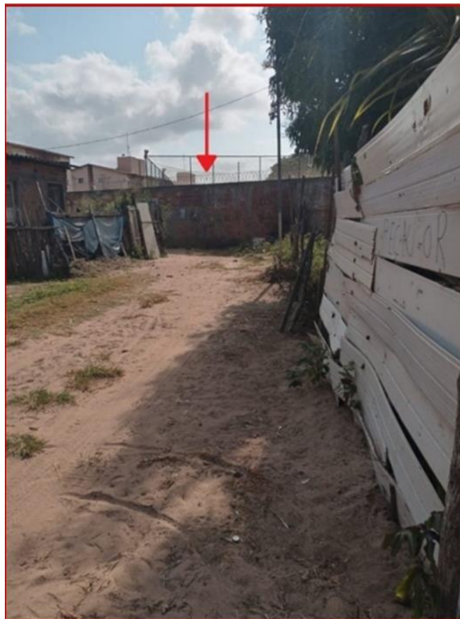
FIGURA 2 – CASA COM MATERIAL RECICLADO E AO FUNDO MURO DO CONDOMÍNIO VILLAGE DEL'ESTE V
