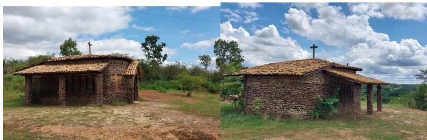
Figura 07: Lateral da Capela de Pedra. Figura 08: Parte posterior da Capela de Pedra.
