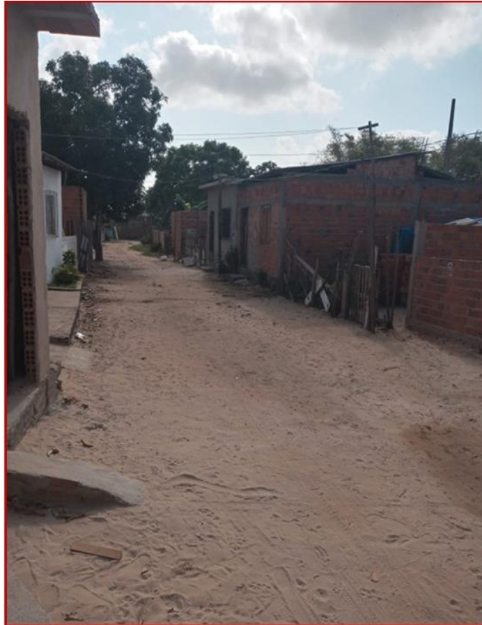
FIGURA 3 – RUA 1 DO RESIDENCIAL E AUSÊNCIA DE PAVIMENTAÇÃO
