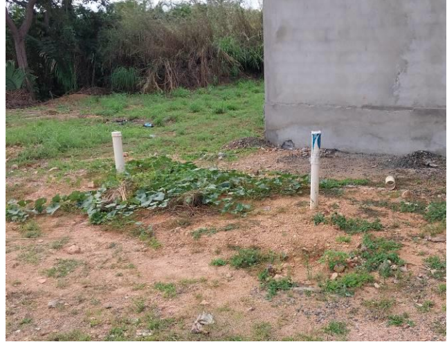
Figura 09: Fossa de evapotranspiração ao lado do Eremitério. Figura 10: Fossa de evapotranspiração na frente do Eremitério.
