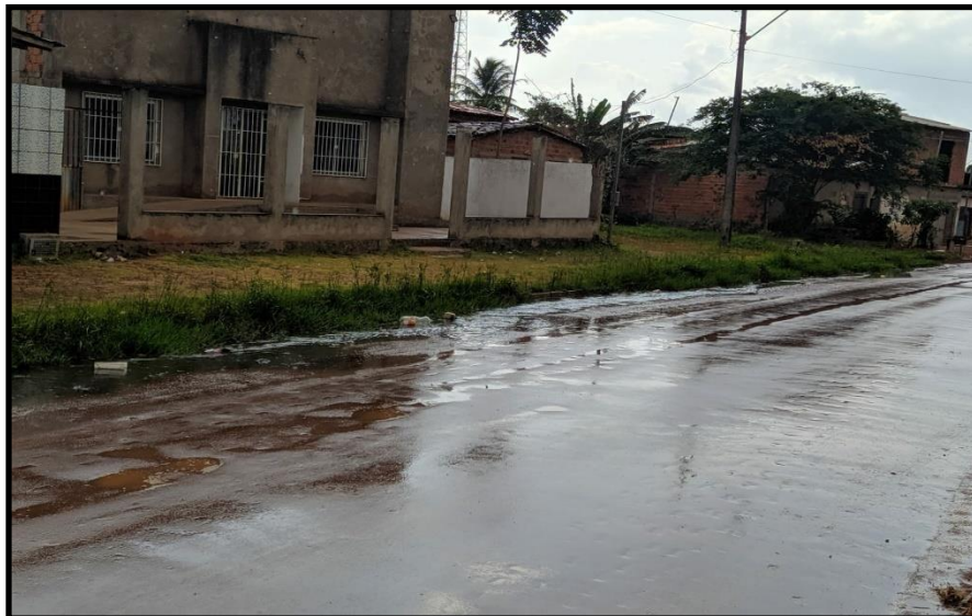
FIGURA 05: ÁGUA ESCORRENDO EM DIREÇÃO ÀS ÁREAS MAIS BAIXAS
