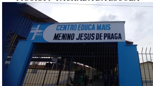
FIGURA 1- FACHADA DA ESCOLA
