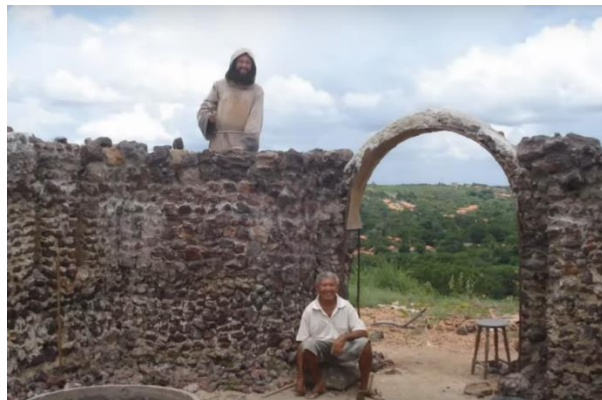
Figura 04: Construção da Capela de Pedra
