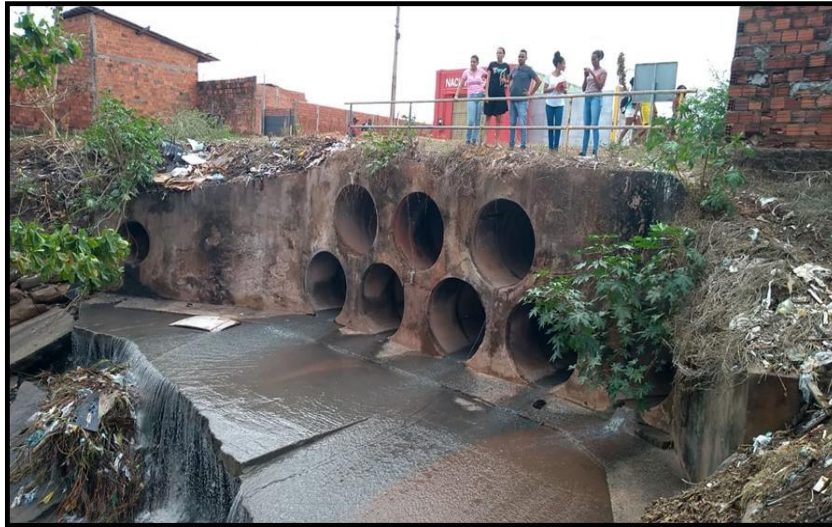
FIGURA 06: INTERVENÇÃO NA MORFOLOGIA DO CANAL PRINCIPAL DO RIO SANTO ANTÔNIO
